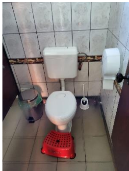
Instalația sanitară existentă
